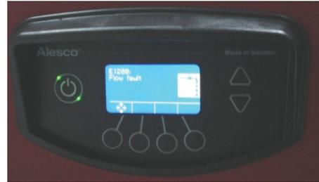
Sicherheitshalber den Sicherungsautomat auch einmal aus- und wieder einschalten, es gab schon Fälle, bei denen nach Transport eine Phase 'wegvibriert' war.
